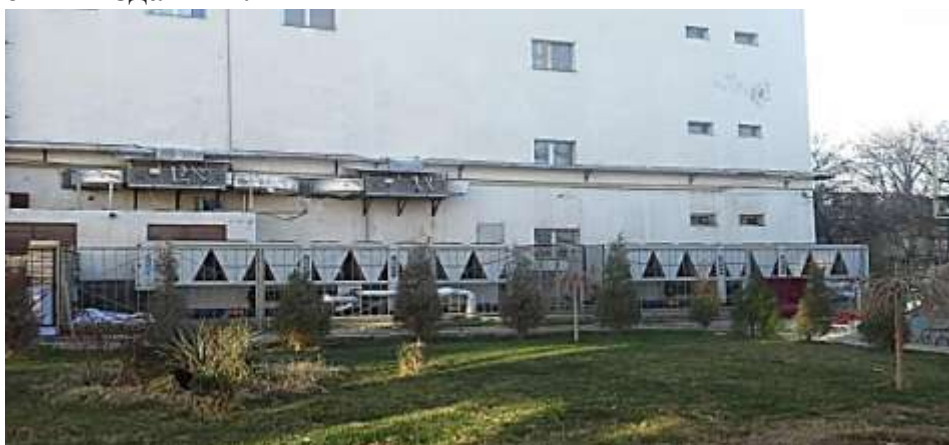
Рис.2. Расположение чиллера рядом со зданием «MEGAPLANET»
