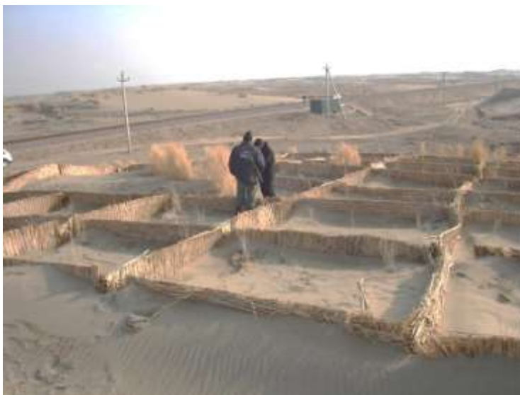
Рис.2. Устройство клеточной защиты на участке Км 20
