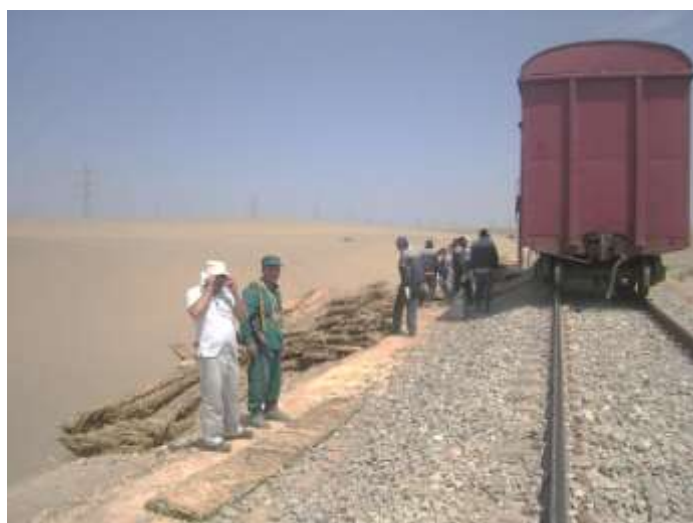
Рис.1. Доставка камышовых мат для механической защиты
