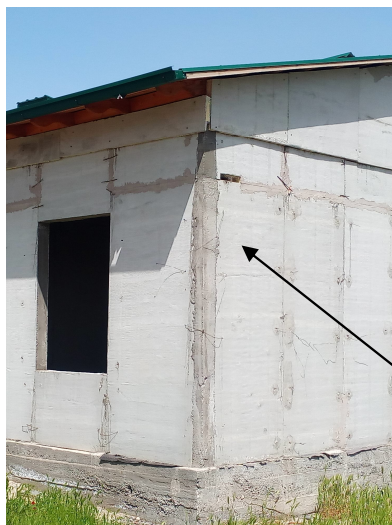
Рис. 2. Узлы жилого дома из цементных сэндвич панелей с железобетонными стойками: а – угол наружных стен; б – место примыкания внутренней стены к наружной; 1 – железобетонные стойки.
