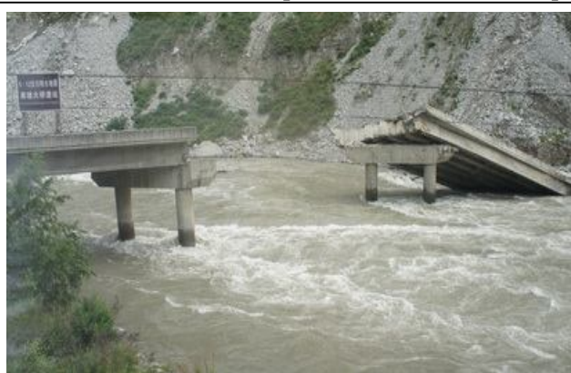
Рис.1.1. Падение пролетных строений автодорожного моста во время землетрясения магнитудой 8 (Китай 2008)
