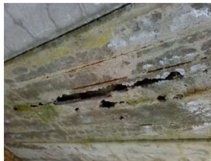
1-Расм. Муҳит таъсирида бетондаги емирилишлар Фойдаланилган адабиётлар
