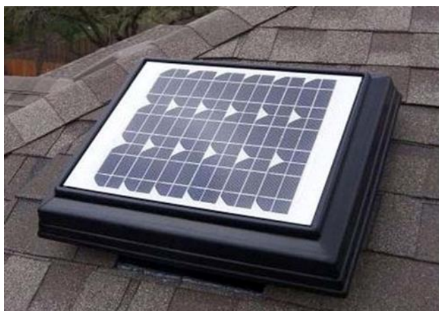
Рис. 2. Полностью автоматизированный мансардный вентилятор, снабженный солнечной батареей
