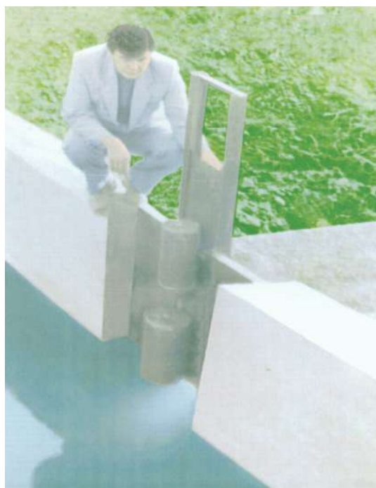
3.3-расм. Қашқадарё дарё ҳавзасининг ўрта табиий сув хўжалиги районида жойлашган Оқработ зовурига тадбиқ этилган коллектор-зовур оқимларини ростловчи иншоот (Холбаев Б.М.)
