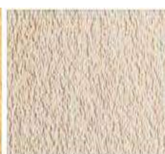
Штукатурка Ceresit CT 137, получена путем затирания пластиковым полутерком (теркой) в одном направлении
