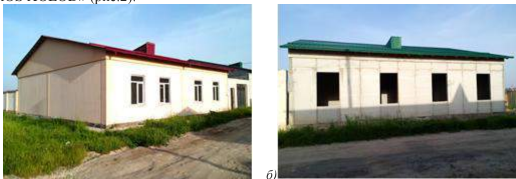
Рис. 2. Жилые дома из цементных сэндвич-панелей: а – построенный дом со скрытым металлическим каркасом; б – строящийся дом со железобетонными стойками в углах наружных стен.
