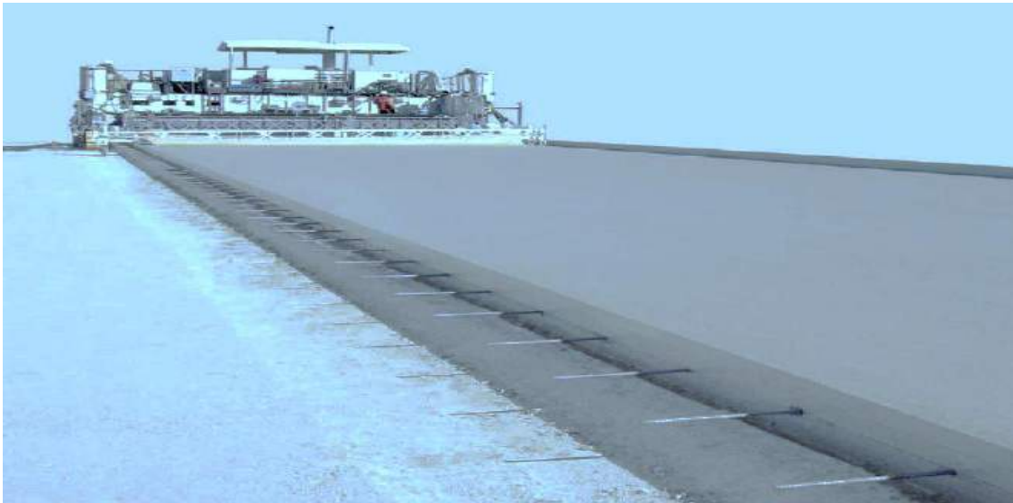
1-расм. Цементбетон қоплама ётқизиш жараёни.
