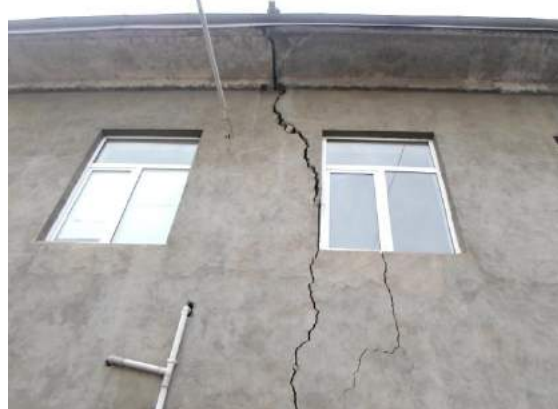
2-расм. Тошкент шаҳар, Олмазор туманида жойлашган бинода авария ҳолатининг пайдо бўлиши: 1-бинонинг умумий кўриниши; 2- гишт-тош конструкцияли юк қутарувчи деворда пайдо бўлган кенглиги 5-7см га тенг бўлган ёриқлар.
