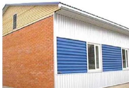
Рис.1. Жилом дом, возведенный с каркасом из ЛСТК, с облицовкой из кирпича и сайдинга.
