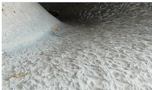
Рисунок 7. Состояние рабочего колеса насосно-агрегата АБМК-I через один год эксплуатации.
