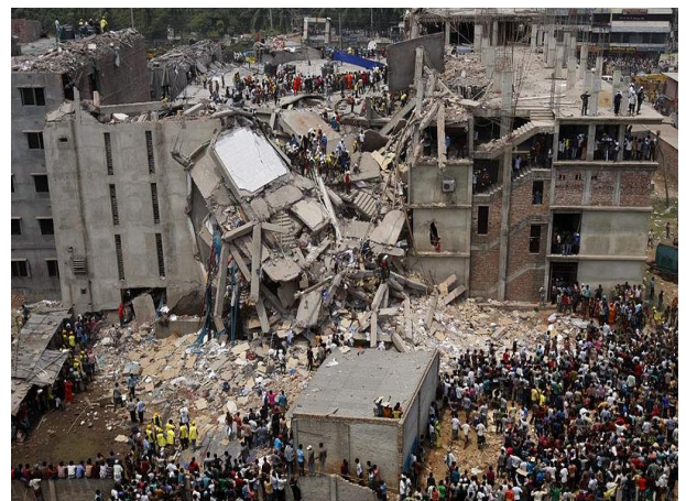
1-расм. Бинода рўй берган бузилишлар туфайли 2013 йил 24 апрель куни 8:45 да бинонинг устки 4 қавати қулаб тушган - Дакка вилояти. (Бангладеш)
