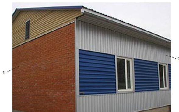
1-расм. ЕПЮКли бинонинг қўриниши: 1 - пардоз ғишт қопламали фасад; 2 - металл сайдинг қопланган фасад.
