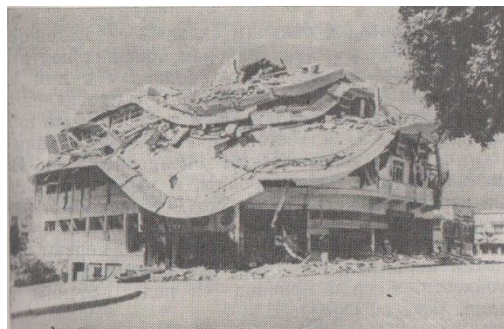
Рисунок 4. Здание с железобетонным каркасом в Агадире [2].
