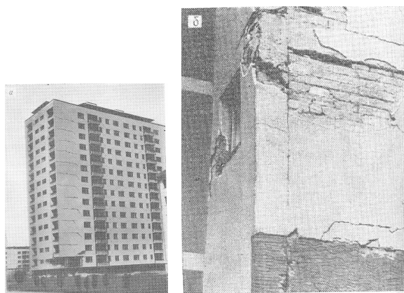
Рисунок 5. Каркасное здание в Скопле: а - 14 этажное; б - повреждение каркаса и заполнения в выступе [2].
