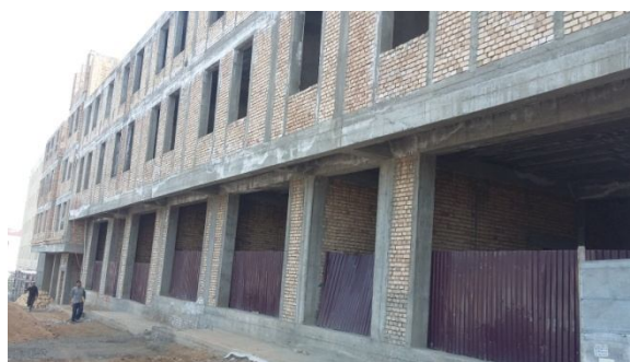
Рис. 9. Многоэтажное здание с консольными перекрытиями
