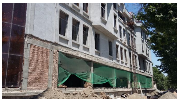
Рисунок 8. Многоэтажное здание с первым гибким этажом
