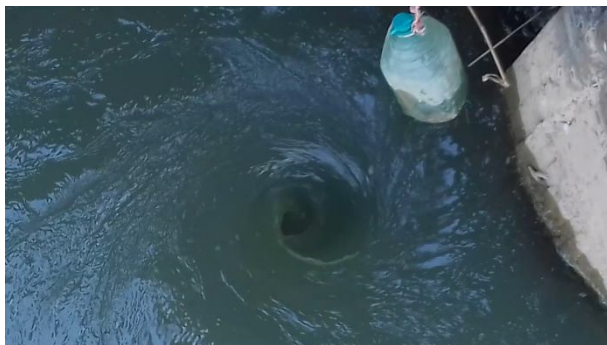
2-расм. Сўрувчи қувурларга сув тақсимловчи иншооти олдида сув уюмасининг ҳосил бўлиши.
