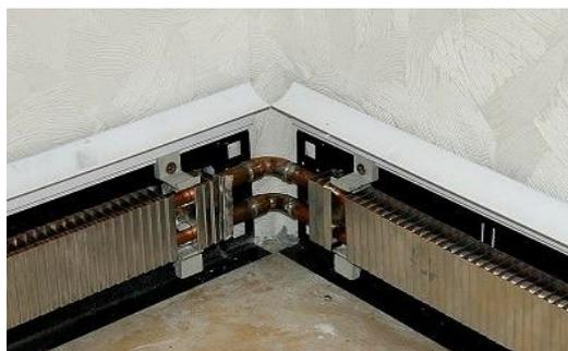
При монтаже участков необходимо обратить внимание на точную обрезку плинтуса и на расстояние от его конца до угла стены. В случае наружных уголков это расстояние равно 3 мм, внутренних  $60 \pm 2$  мм. Уголки крепятся за счет ранее вставленной в плинтус стопорной вставки.
